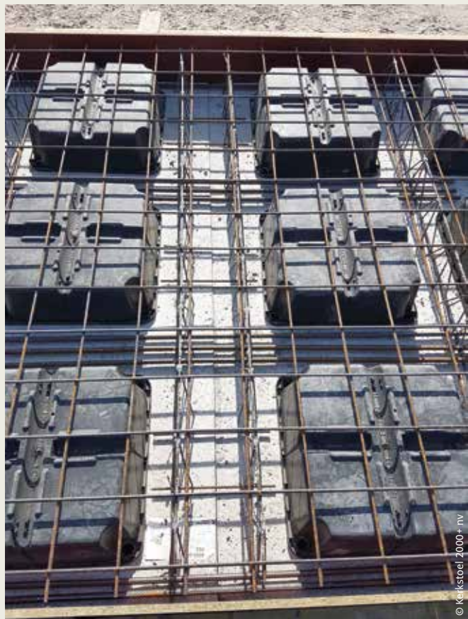
Fig. 3. Breedplaten met holtevormers waarbij de tralieliggers zich op 90 mm van de voeg bevinden.
