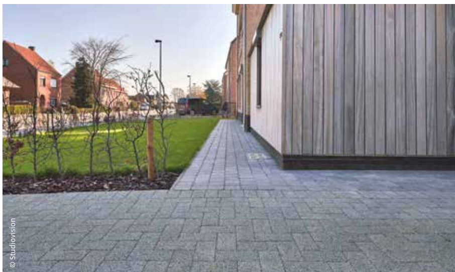
Oplossingen van de FEBESTRAL-fabrikanten: Waterdoorlatende verharding
