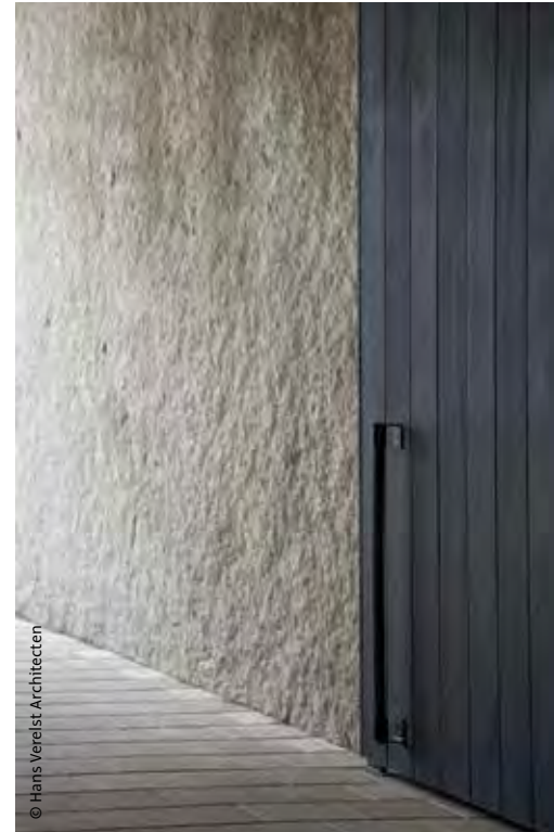
Zachte, rotsachtige structuur van de gevelpanelen
