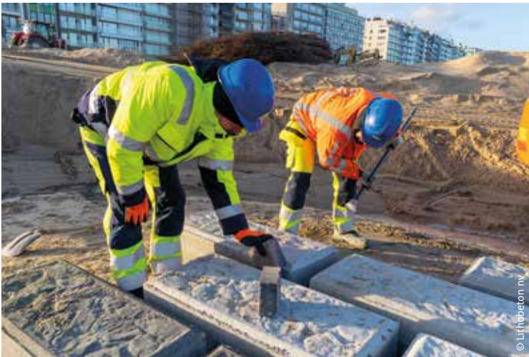
Door middel van afstandhouders worden voegen gecreëerd die uiteindelijk worden opgevuld met kiftbeton.
