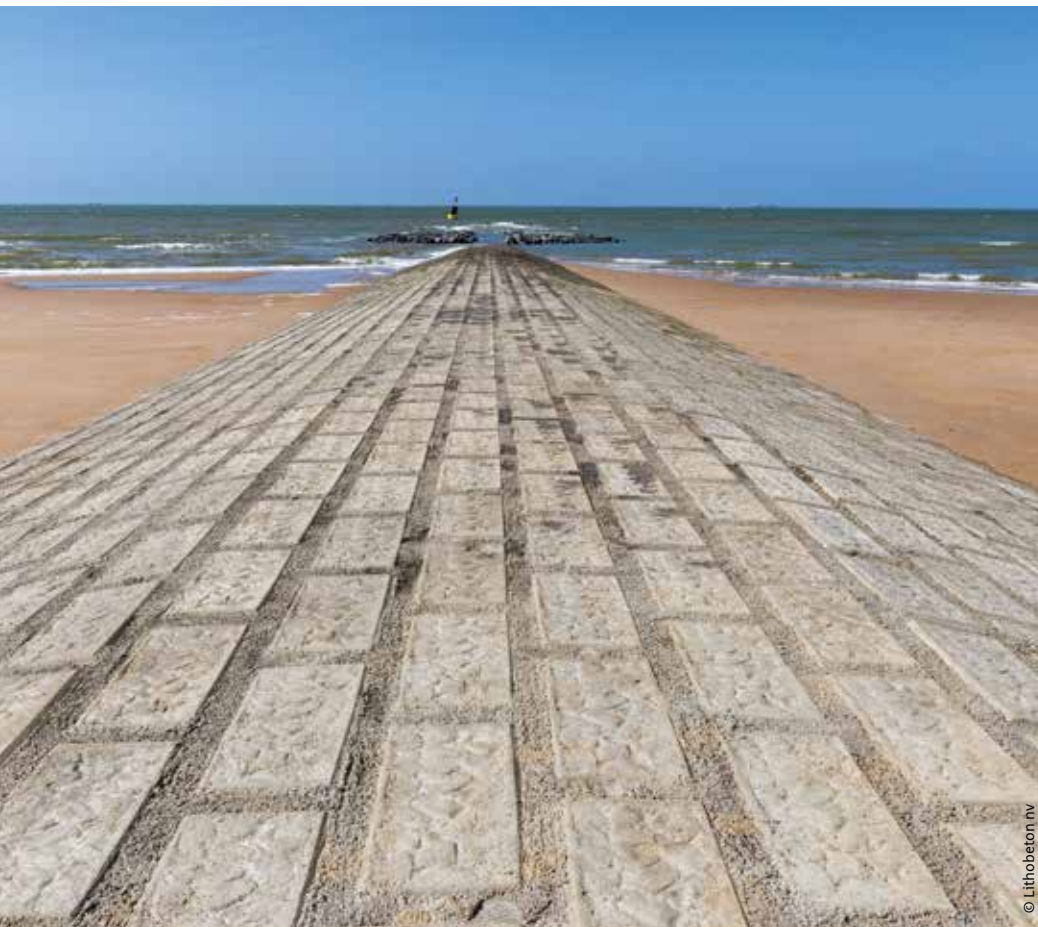
De realisatie van 4 nieuwe strandhoofden in Wenduine is in een eindfase beland. La réalisation de 4 nouveaux brise-lames à Wenduine est entrée dans sa phase finale.
