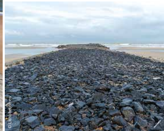
Per strandhoofd werden 24.000 ton breuksteen en ongeveer 3.000 m³ beton voor funderingen en voegwerken gebruikt. Par brise-lame, 24.000 tonnes de pierre concassée et environ 3.000 m³ de béton pour les fondations et le remplissage des joints ont été utilisés.
