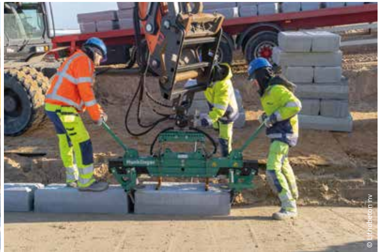
Een hydraulische klem zorgt voor een efficiënte plaatsing van de cyclopienblokken.
