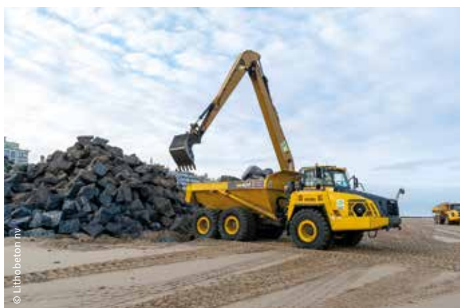
Voor de koppen werd vernieuwde breuksteen (blauwe hardsteen) aangeleverd vanuit Henegouwen.
